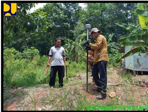
**Gambar 13.2** Pengukuran dan Pemasangan Patok Batas-Batas Tanah Aset Pemkab
