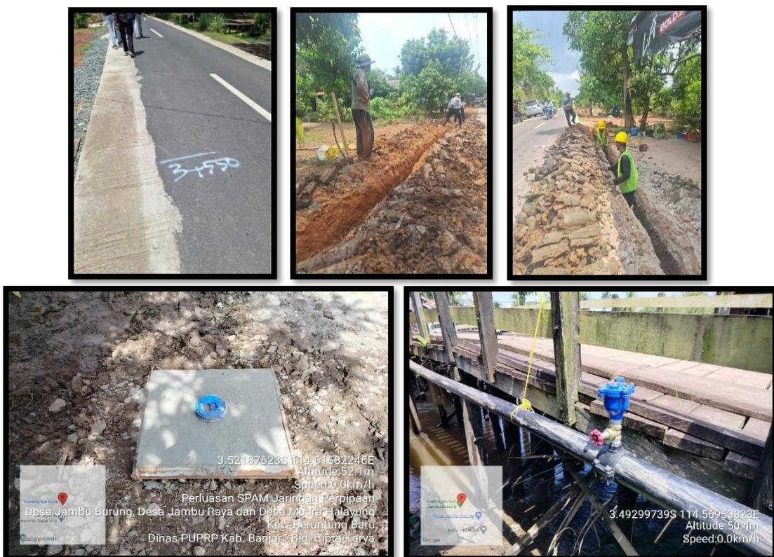
**Gambar 4.6** Pekerjaan Perluasan SPAM Jaringan Perpipaan Desa Jambu Burung, Desa Jambu Raya dan Desa Muara Halayung Kec. Beruntung Baru
