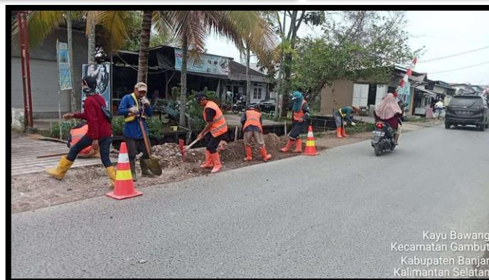
**Gambar 1.7** Pemeliharaan Berkala Jalan (Bahu Beton)
